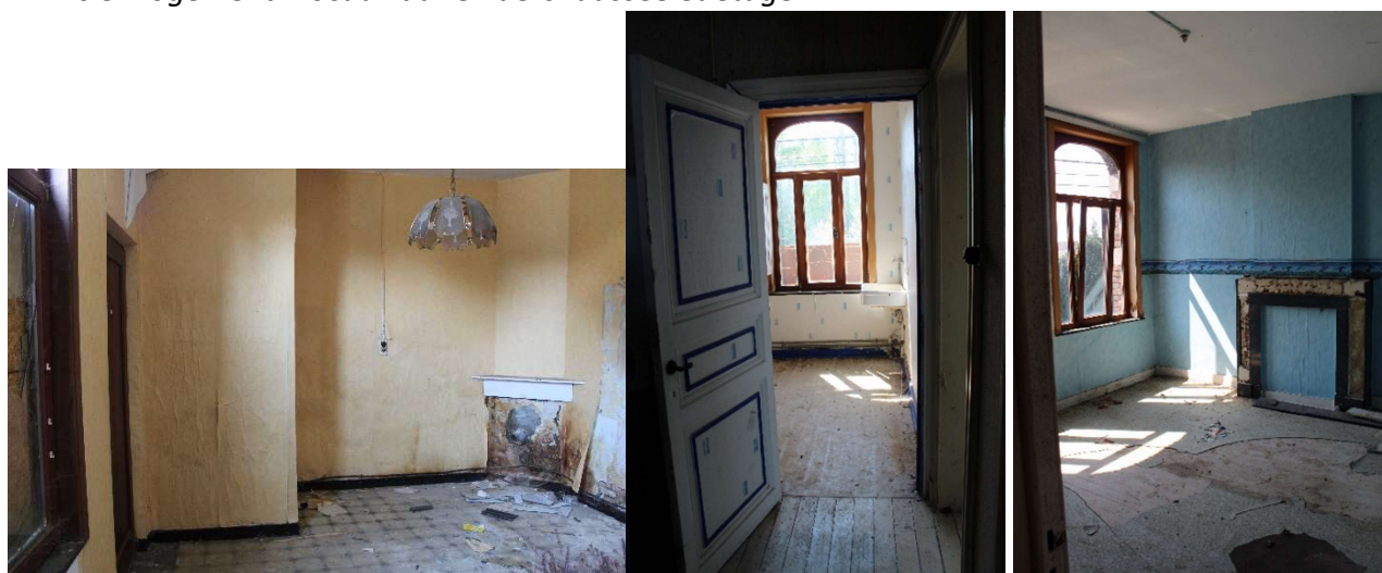
Ancien logement : locaux du rez-de-chaussée et étage
