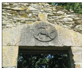
Linteau roman en bâtière avec représentation de l'agneau pascal (12 e /13 e siècle) au-dessus de la porte du mur méridional de la chapelle Saint-Sauveur.
