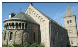
Avennes. L'église Saint-Martin conserve son chœur à abside attribué au 12 e siècle, avec sa galerie à colonnettes, en dépit des lourdes transformations du début du 20 e siècle.
